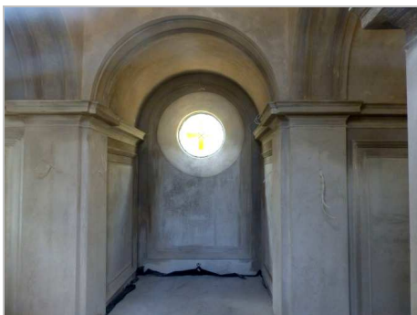
Ryc. 10. Wnętrze kaplicy grobowej Tollów
