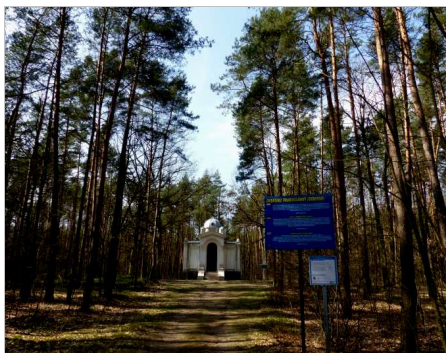
Ryc. 7. Widok na mauzoleum Tollów od strony drogi wjazdowej – ok. 200 m na zachód od trasy Uniejów–Dąbie
