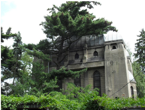
Ryc. 4. Kaplica grzebalna rodu Kindlerów Źródło: fotografia autorki
